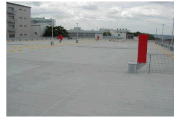
駐車場スラブ面強化(防塵)
