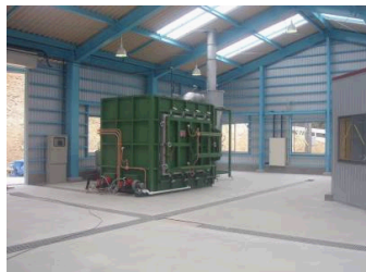
工場土間防塵
