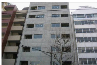
マンション外壁疎水材塗布
