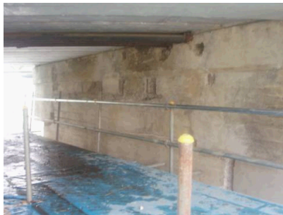
橋梁劣化防止
