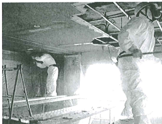
写真5 アスベストの除去作業
