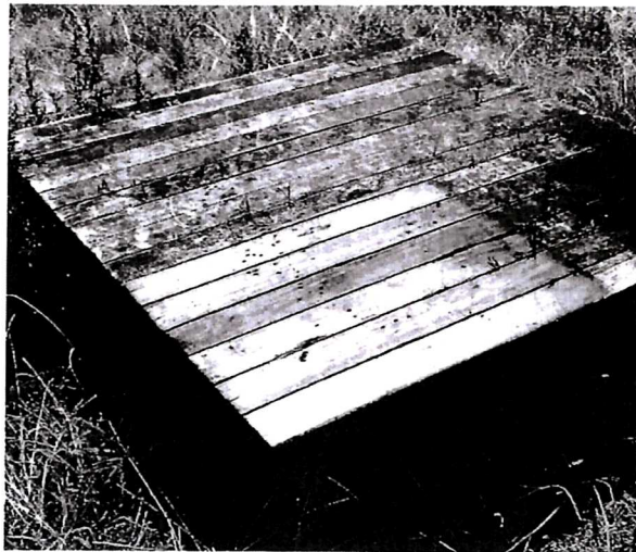
写真2 WOOD-Rを使用した洗浄状況
