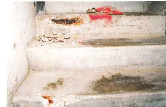
劣化、ひび割れ、汚れのひどいコンクリート階段。
